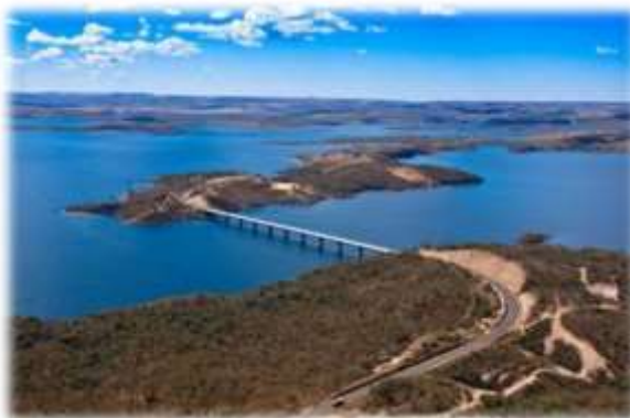
Visão do reservatório no município de Catalão/GO
